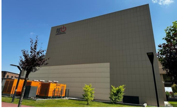
Şekil 5. Balıkesir Avlu Kongre ve Kültür Merkezi Binası (Furkan Topal arşivi)
