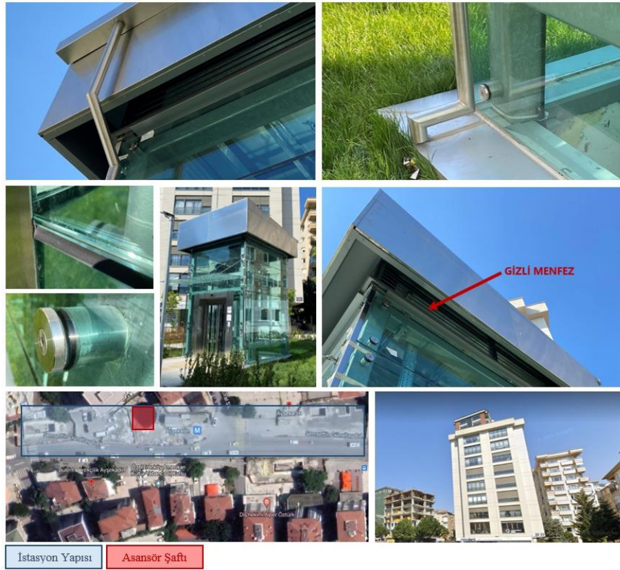
Şekil 6. Ayşekadın İstasyonu uydu görüntüsü (Earth Google), Asansör çevresi yapı cepheleri ve ağaçlandırma (Mermi, 2023)
